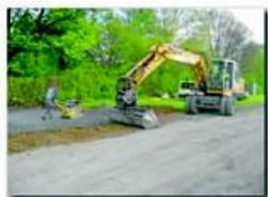
Erdarbeiten bei der Erstellung des Boulodroms.
