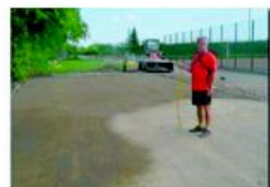
Neubau Boulodrom: Klaus Heine.
